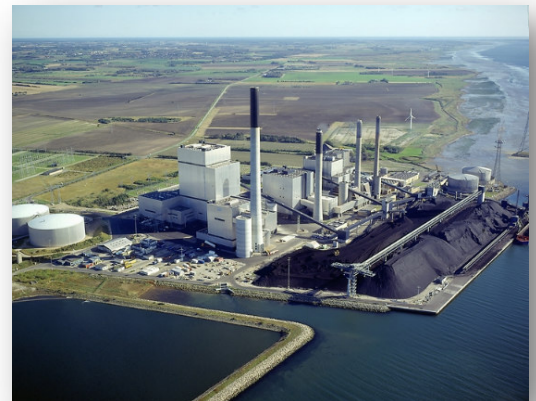
Photo: Aalborg Energikoncern. Nordjyllandsværket Power Plant.
