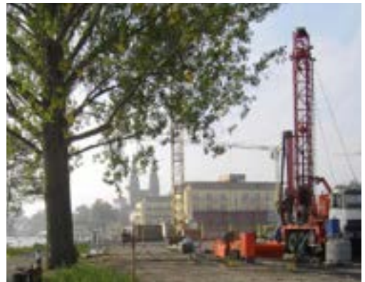
Abbildung 14: Bohranlage in Neuruppin (Quelle: SWN)
