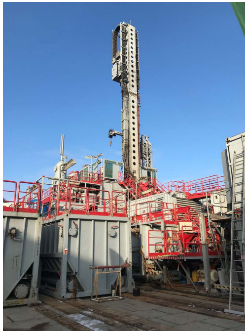
Abbildung 9: Bohrturm Tiefengeothermie (Quelle: MWAE)
