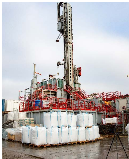
Abbildung 23: Tiefengeothermie Bohranlage in Potsdam (Quelle: MWAE)
