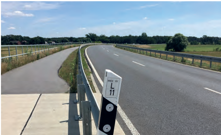
Abbildung 30: Ortsumgehung Breese auf Straßendamm (Teilabschnitt 1) Quelle: Landesrechnungshof Brandenburg
