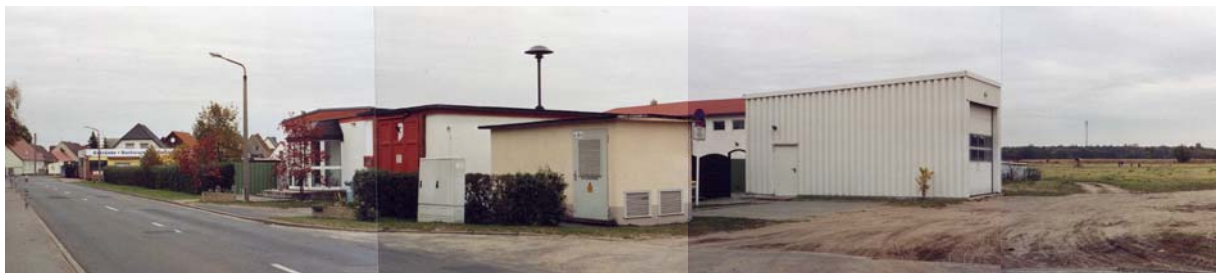
Gebäude der Freiwilligen Feuerwehr, Gemeindehaus und Trafostationen
