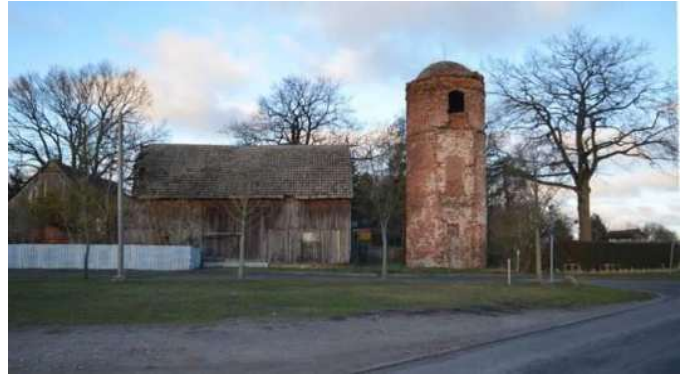
Abb. 45: Blick auf den Treppenturm von Süden
