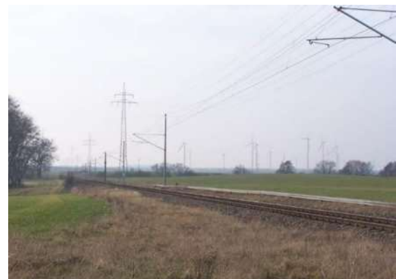
Abb. 31: Eisenbahn- und Hochspannungstrasse, Fotostandort 30, Blick nach W
