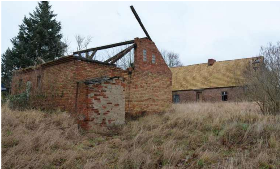
Abb. 79: Zustand der Gebäude im Januar 2019
