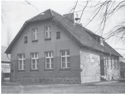
Das ehemalige Schulgebäude von Kummerow dient heute als Dorfgemeinschaftshaus.
