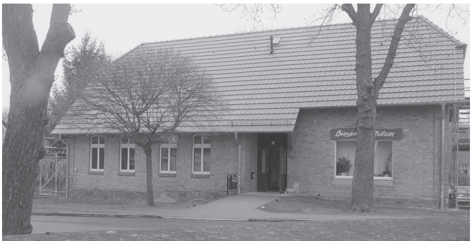
Mit der Dachsanierung wurde der Urzustand des Daches mit seinen auffälligen Flugsparren wiederhergestellt.
