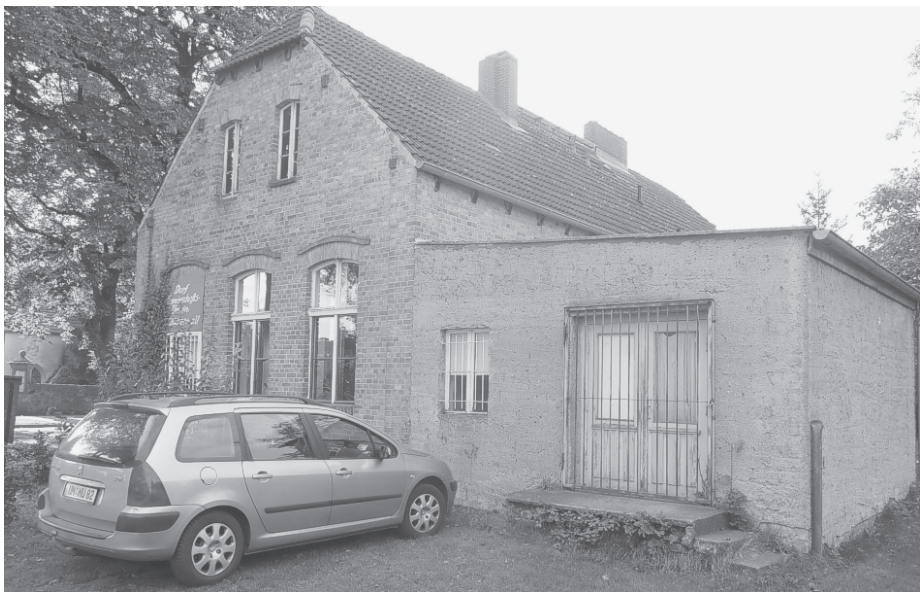
Das Gemeindehaus vor seiner Sanierung mit dem hofseitigen Anbau.
