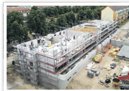
Baumaßnahme „Augustiner Tor“
