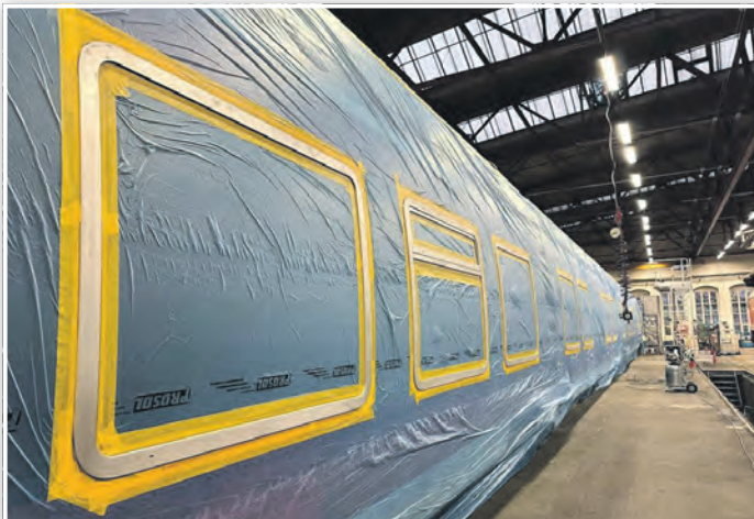
Die Fensterrahmen werden abgeschliffen, von Rost befreit ...
